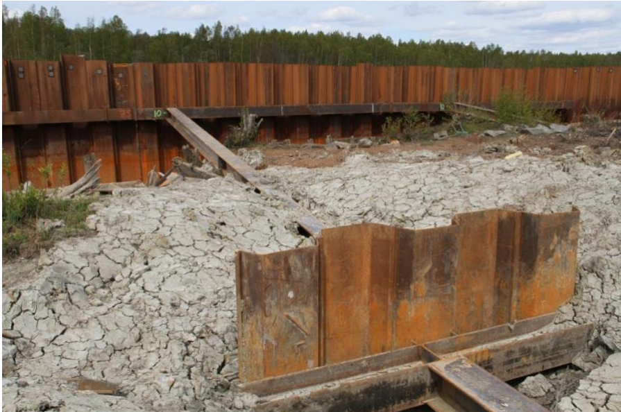
Figur 3: I bakgrunden syns sponten som är sammansvetsad med mothållssponten som kan ses i förgrunden (Ale kommun, 2014)
